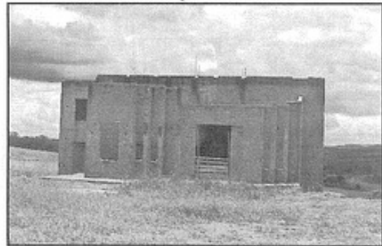
Obras da futura sede da Fraternidade Irmão Glacus de São Gonçalo do Pará
