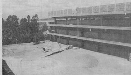
Paredes levantadas: etapas de continuação das obras
